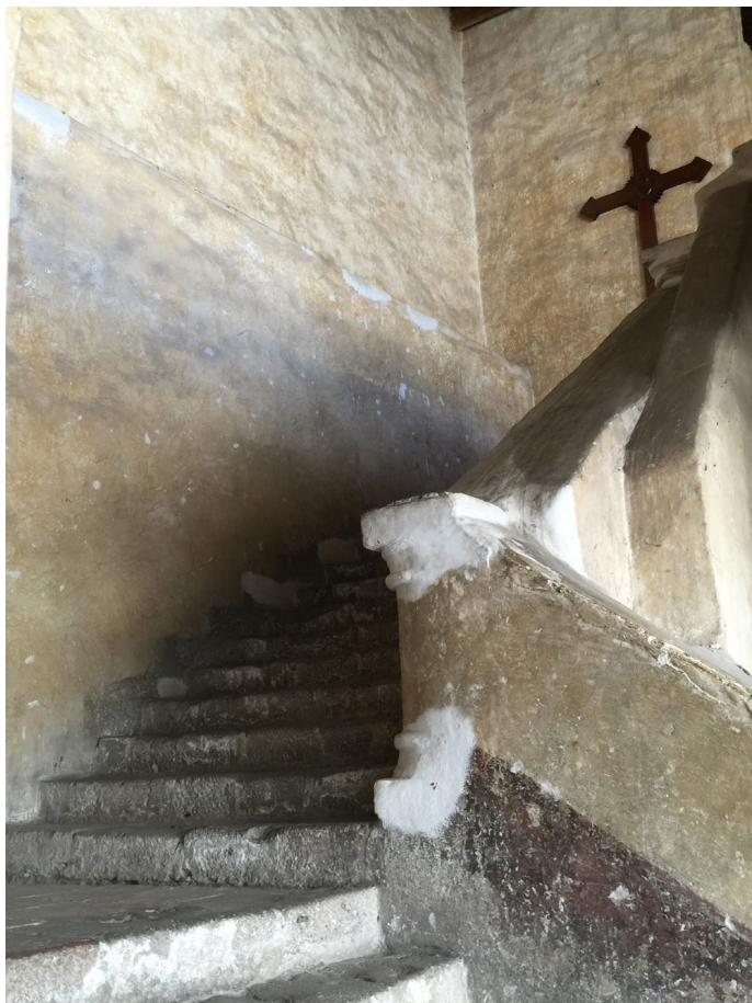
2-16 Escalera del claustro de San Juan Bautista, Metepec (Héctor Serrano-Barquín)
