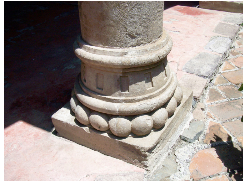
1-21 Detalle del claustro del Convento de Acolman, México (René Lauro Sánchez-Vértiz Ruiz)
