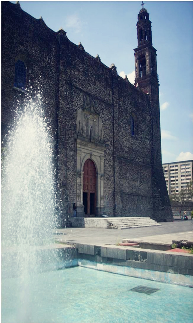
i-3 Colegio de la Santa Cruz en Tlatelolco, ciudad de México (Héctor Serrano- Barquín)
