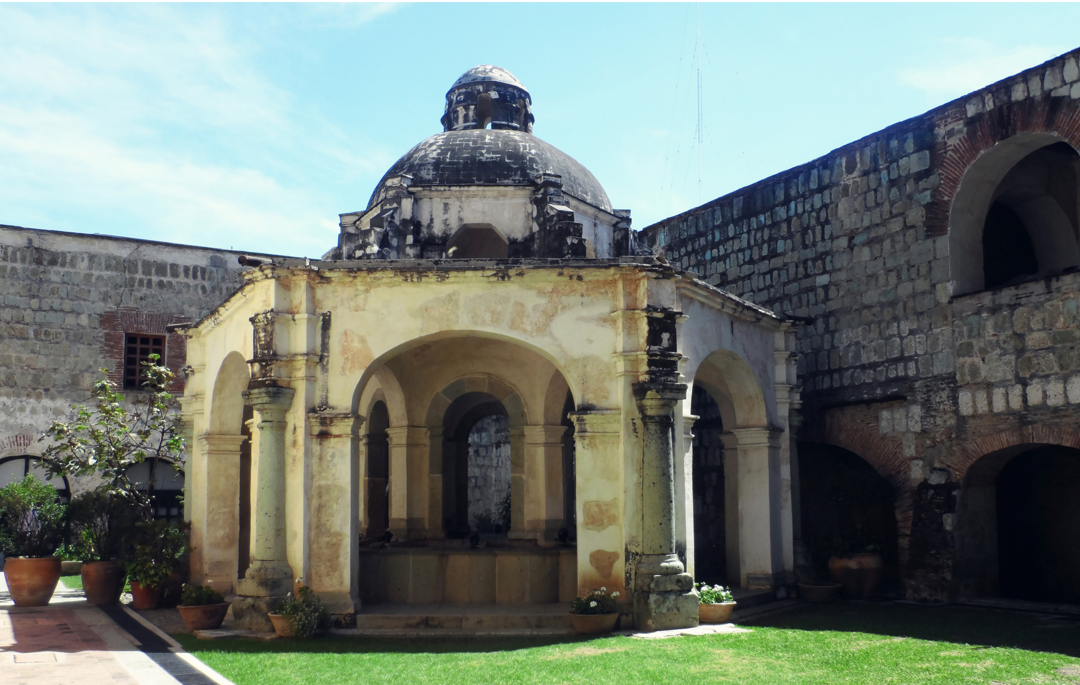
i-17 Lavaderos monumentales del Convento de Santa Catalina de Siena, Oaxaca (Héctor Serrano-Barquín)
