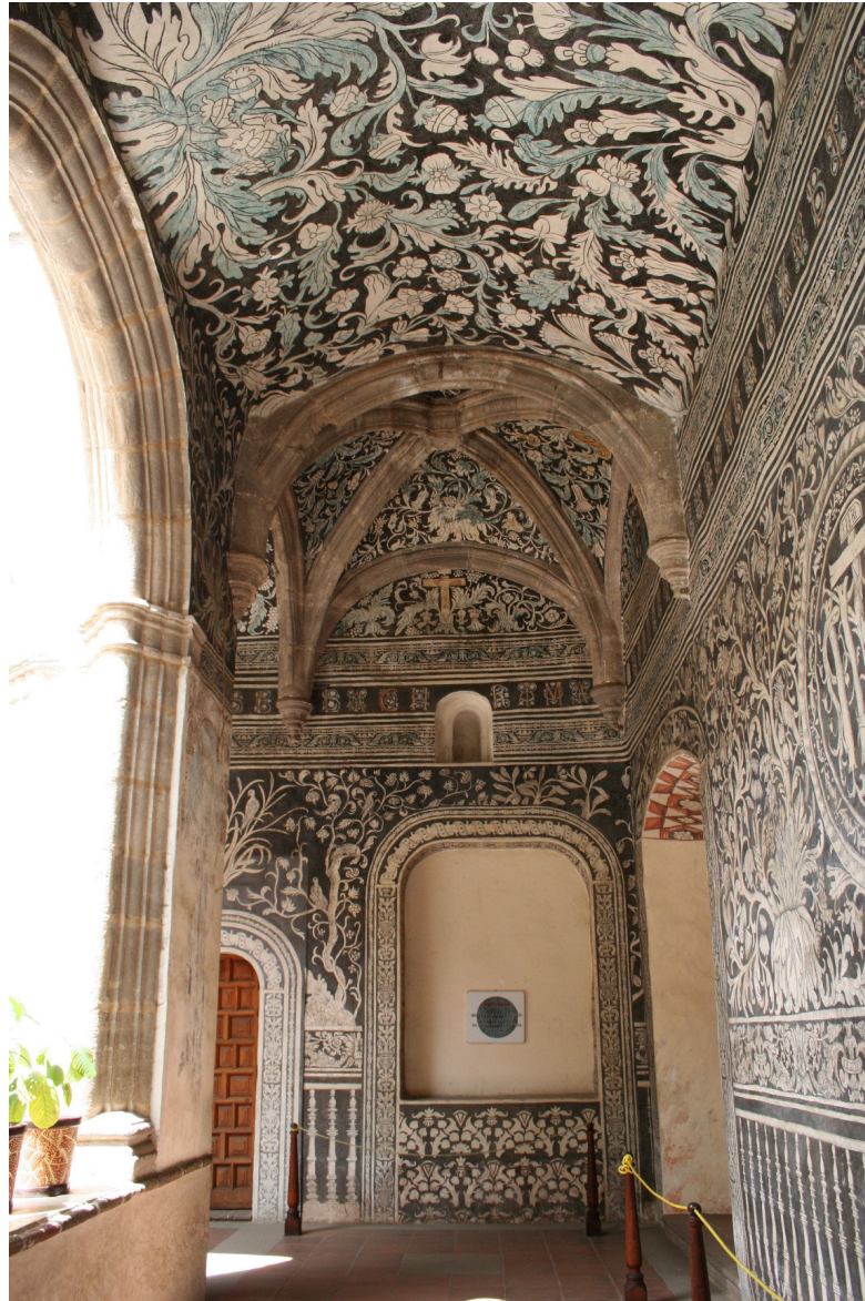
2-13 Bóveda, Convento de Malinalco (Héctor Serrano-Barquín)
